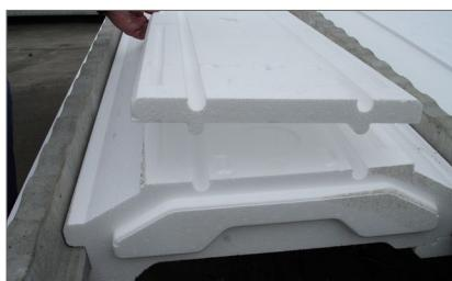
■ **Clipser les éventuelles rehausse**s conformément au plan de pose.
