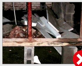
La pose des étais est une phase essentielle pour la mise en sécurité du chantier.
