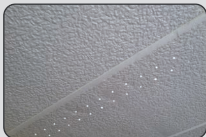
Op de vulstenen zijn er perforaties voorzien.
