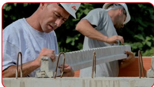
De balkjes plaatsen.
