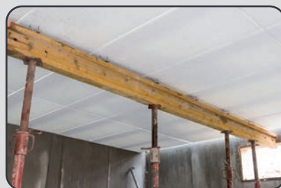
Plaats de houten balk bovenop de schorenrij tegen de afstandsringen, zonder deze te forceren.
