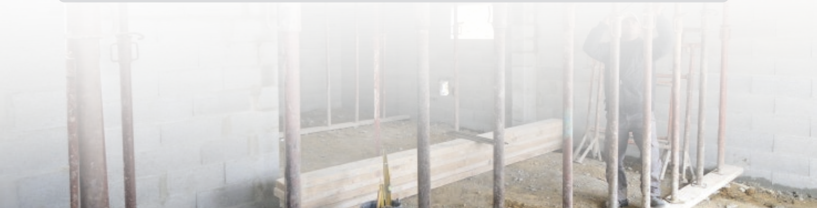
Plaats de houten balk bovenop de schorenrij tegen de afstandsringen, zonder deze te forceren.
