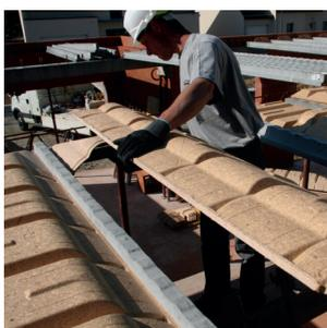
Pour réaliser 100m<sup>2</sup> de plancher à poutrelles et entrevous, un travailleur doit transporter et mettre en place environ 860 entrevous B12 de 13.9kg, soit 12 ton, alors que la même surface réalisée en Rectolight ne demande que 115 entrevous de 5,74kg, soit 0.66 ton.
